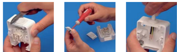
A bevezető tömítés kivétele, majd átlukasztása után a kábel könnyen bevezethető.
